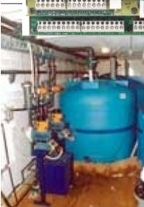
АСУ ТП станции обеззараживания воды на привозном гипохлорите натрия предназначена для автоматизированного управления процессом приготовления раствора гипохлорита натрия заданной концентрации и дальнейшего его дозирования с целью обеззараживания питьевой воды, поступающей на станцию по трем самотечным водоводам и подаваемой в гг. Кронштадт и Ломоносов.
