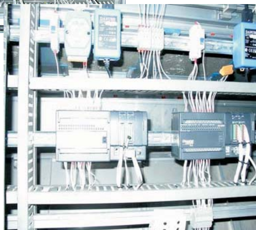
Шкаф управления двух красильных барабанов
